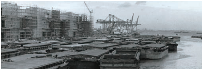
供用開始後の本牧A突堤
