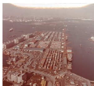
全面供用された本牧A突堤
