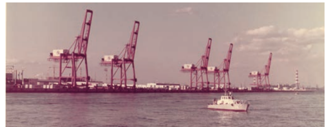
本牧ふ頭のガントリークレーン
